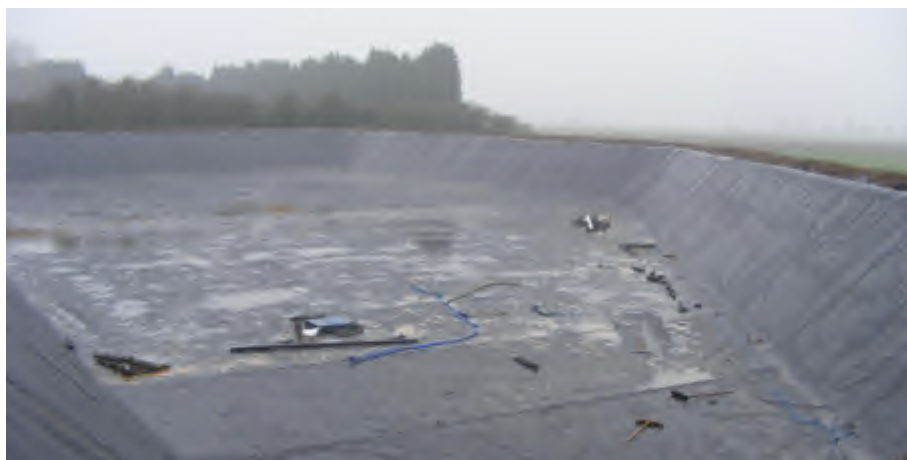
Рисунок 4. Изображение готового пожарного водоема
