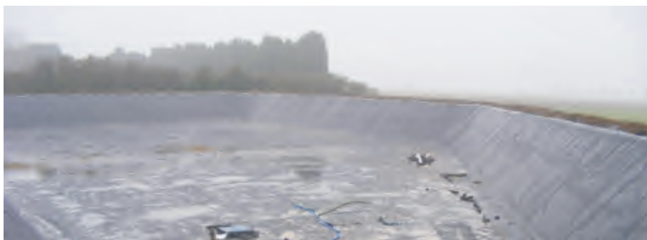
Рисунок 4. Изображение готового пожарного водоема
